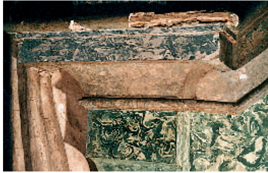
8 St. Michael in Schwäbisch Hall. Holzcorpus, Malschichten platzen ab (vgl. auch Abb. S. 92)
