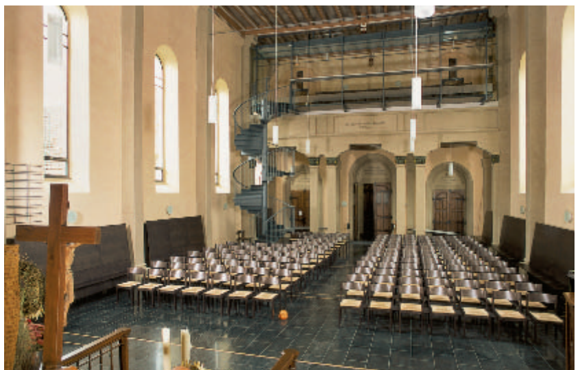
7 Bretten-Gölshausen, evangelische Kirche, Blick durch den Kirchenraum auf die umgebaute Empore.
