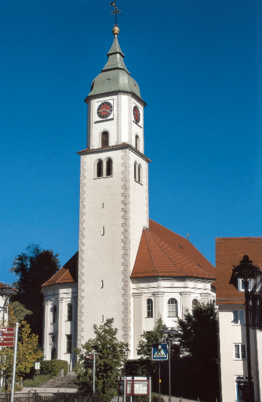
2 Bad Wurzach, katholische Stadtpfarrkirche St. Verena, 1775–77.
