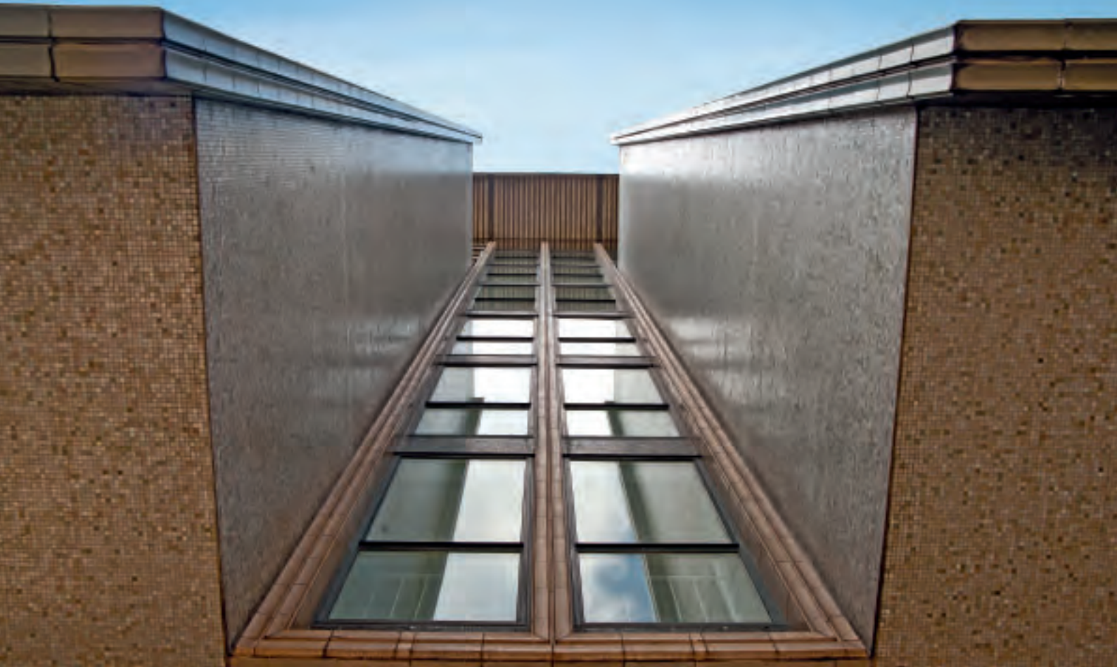
5 Zeittypischer Fassadenrücksprung an der Gebäudeschmalseite.
