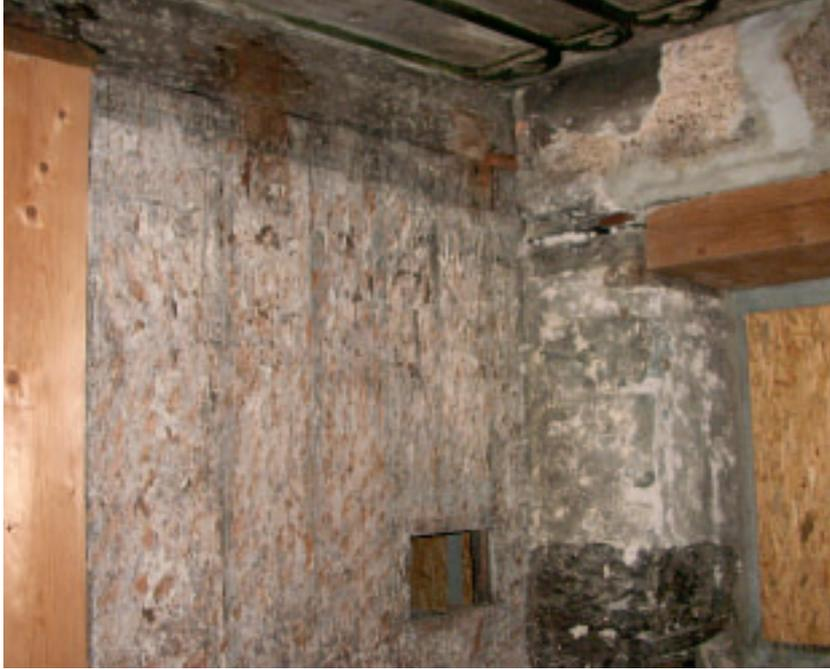
8 und 9 Die Bohlenwände der Bohlenstube im ersten Obergeschoss vor und nach Instandsetzung und ergänzender Reparatur.
