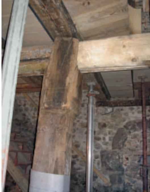
5 Mächtige Holzständer großen Querschnitts mit kopfzoniger Schale, die den Unterzug aufnimmt, auf dem die kräftige Balkendecke der Halle aufliegt. Etwa in Höhe des Ständers zeichnet sich im Mauergefüge der östlichen Giebelwand eine Türöffnung mit aufwendig gearbeitetem Rundbogenabschluss ab. Blick von der Halle zum Treppenaufgang vor Einbau der vom Brandschutz geforderten Abtrennung.
