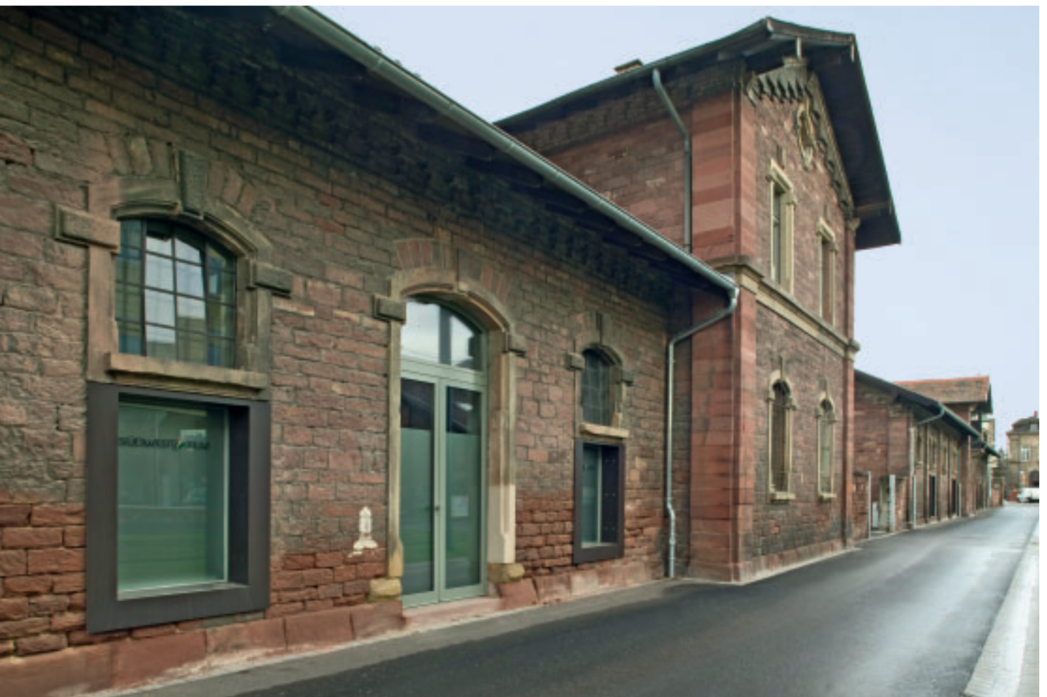
3 Alter Schlachthof 17 und 15, ehemaliges Stallgebäude, zusätzliche Fenster mit Stahlzargen.
