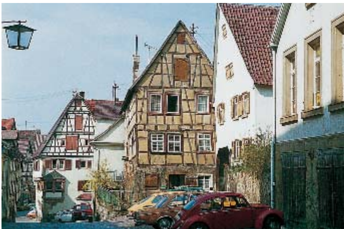
12 Gebäude Corneliastraße 40, 1978 und 2001.
