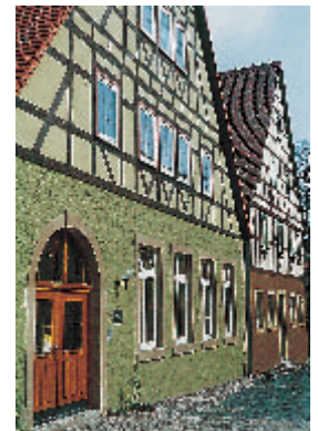
9 Gebäude Burgviertel 21/23, Nord- und Süd-fassade, 1978.
