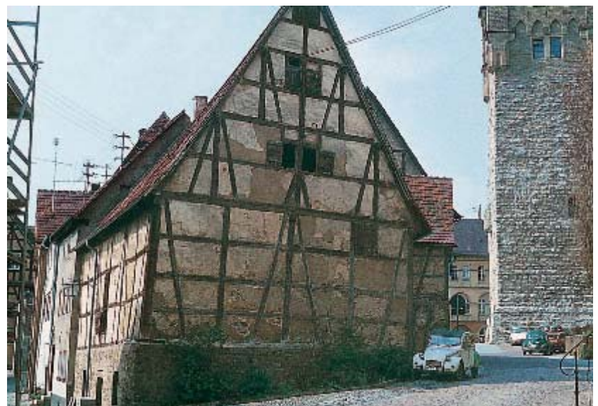
10 Blick auf Burgviertel 16 und Schafgasse 6/8, 1980.
