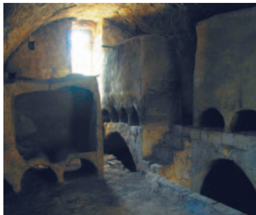
6 Innenraum des typischen palästinensischen Bauernhauses (R1). Die Treppe, die über den tiefer liegenden Flur führt, erschließt das höher gelegene westliche Zwischengeschoss. Deutlich sind die großen Vorratsspeicher aus Lehm (khawabi) zu erkennen.
