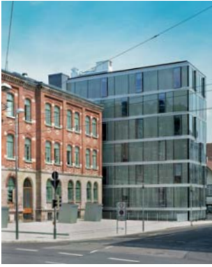
Das ehemalige Schelztor-Gymnasium in Esslingen am Neckar, heute Sitz der Zentrale des Landesdenkmalamtes Baden-Württemberg. Rechts der Erweiterungsbau. Blick Ecke Berliner Straße/Martinstraße.
