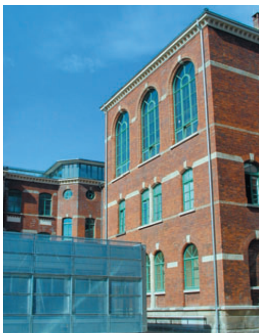
12 Mittelrisalit, Innenhoffassade, Vorzustand.
