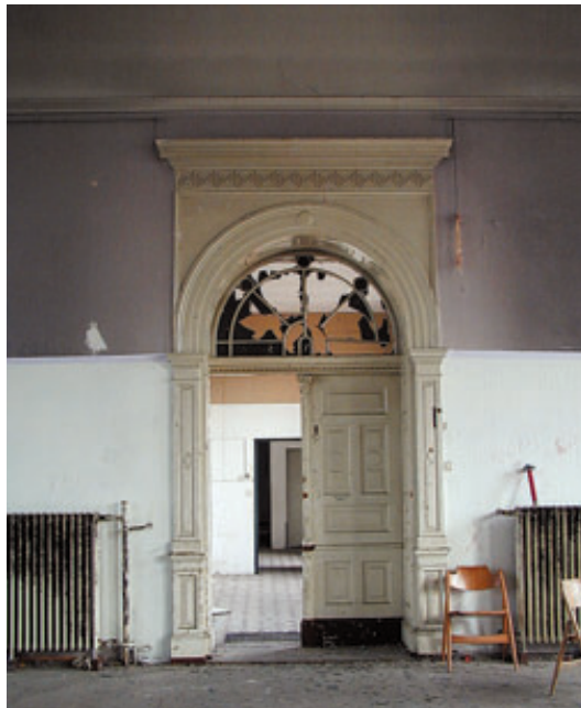
20 Ehemaliger Festsaal, vor Baubeginn.
