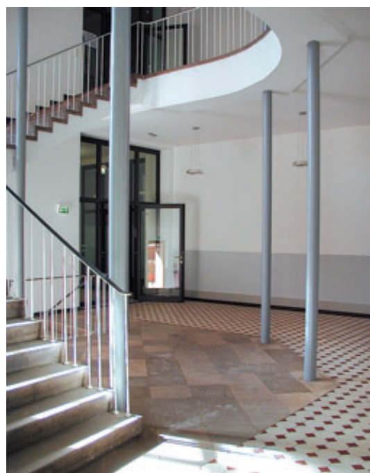
8 Treppenhaus Südflügel, Erdgeschoss.
