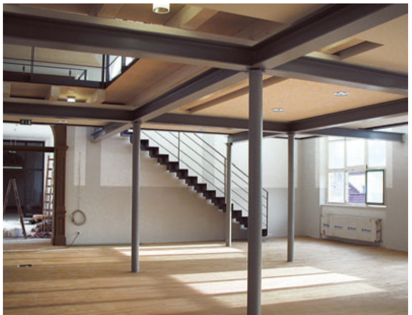
21 Ehemaliger Festsaal während des Umbaus zur Bibliothek.
