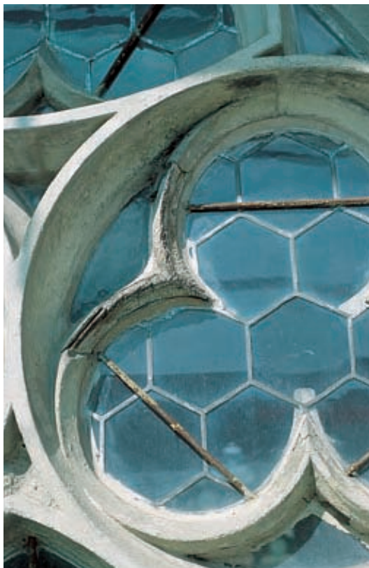
4 Alte, vermutlich barocke Maßwerkergänzungen aus Eichenholz an einem Salemer Maßwerkfenster.
