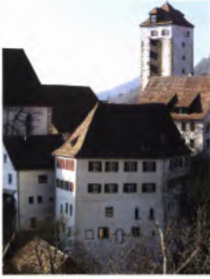
Horb am Neckar, Blick auf die Altstadt mit dem „Klösterle“ nach der Instandsetzung der Anlage. Zustand 2000.
