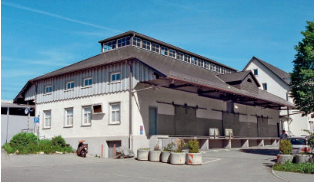
4 Bahnhofsgüterhalle von 1923 von Südosten.
