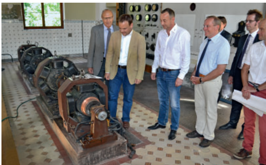
Ulf Bräutigam, Eigentümer des Laufwasserkraftwerkes in Marbach, erläutert Staatssekretär Ingo Rust die verbliebene technische Ausstattung, darunter ein Transformator. Im Hintergrund die historische Schaltwand.
