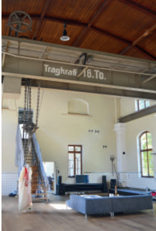
Die Turbinenhalle des ehemaligen Laufwasserkraftwerkes in Marbach dient heute als Atelier des Bauherren. Beim Umbau dieses technischen Denkmals zu Wohnzwecken konnte hier außergewöhnlich viel originale Ausstattung erhalten werden.
