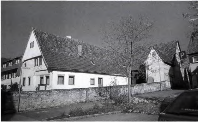
2 Ansicht der ummauerten Hofanlage.
