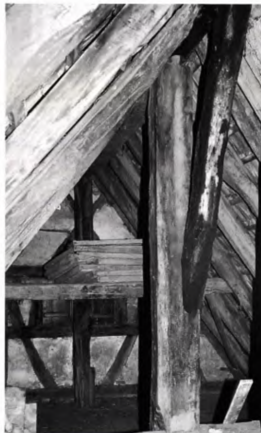
5 Gärtringen, Kirchstraße 20. Firstständerkonstruktion im Dachbereich mit Firstständer, Firstpfette, Kopfband sowie jüngerem Gespärre. Trotz umfangreicher späterer Veränderungen ist insbesondere im Dachwerk die ursprüngliche Konstruktion noch über weite Strecken ablesbar geblieben.
