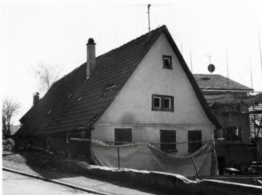
6 Dapfen, Oberdorfstraße 46. Blick auf die westliche Giebelseite. Hinter dem unscheinbaren Äußeren steckte bis zum kürzlichen Abbruch einer der am umfangreichsten erhaltenen spätmittelalterlichen Firstständerbauten der Region.
