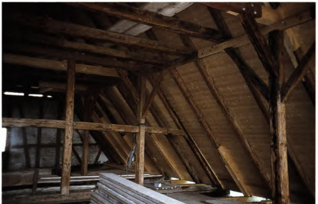
7 Fortgeschrittene Reparatur der Dachkonstruktion: Zerstörte Hölzer wurden durch neue ersetzt. Zustand Mai 2000.
