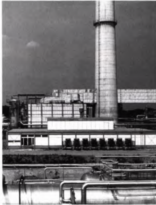
4 Messwarte im Raffineriegelände, Aufnahme unmittelbar nach der Fertigstellung.
