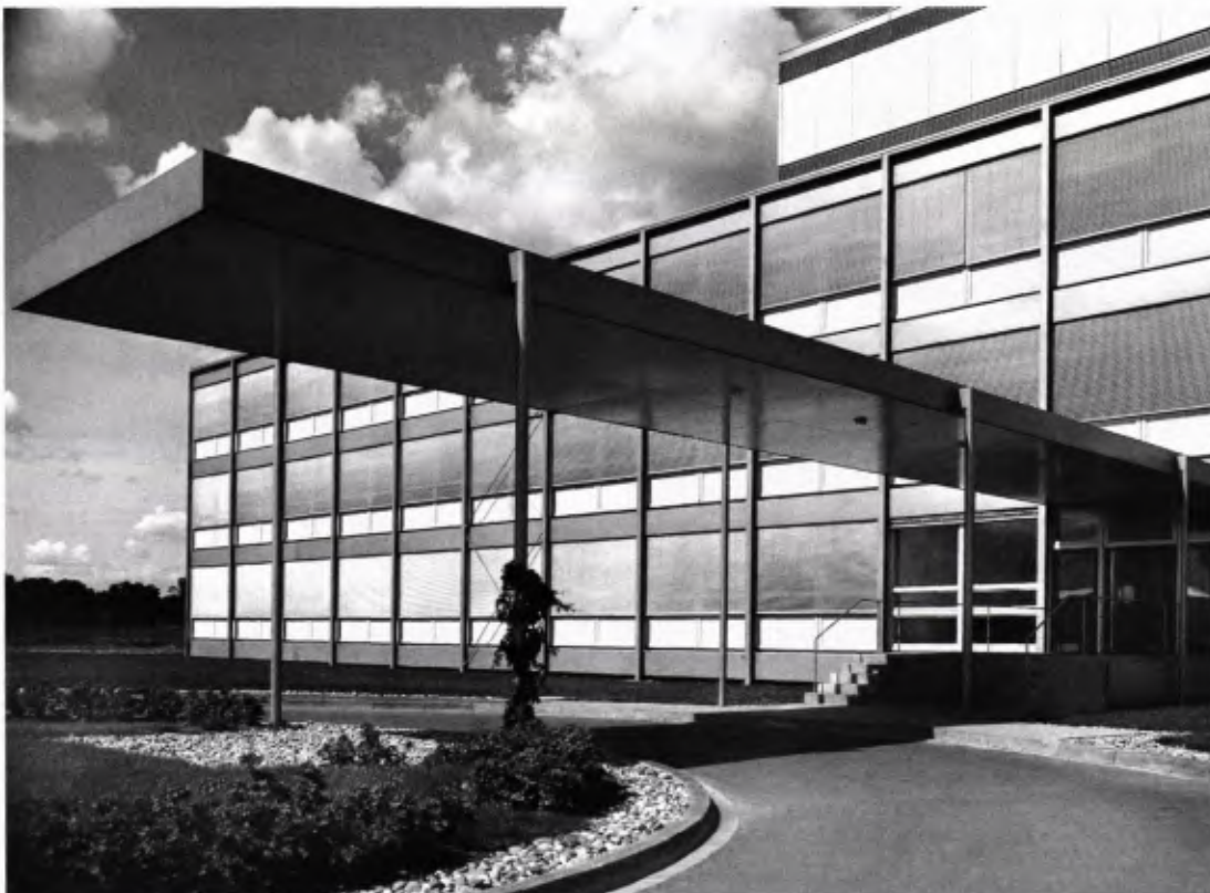
1 Karlsruhe, Verwaltungsgebäude der DEA-Scholven-Raffinerie, unmittelbar nach der Fertigstellung. Eingangsbereich des dreigeschossigen Gebäudes. Das von grazilen Stützen getragene Vordach greift weit über die kreisförmige Vorfahrt hinaus.
