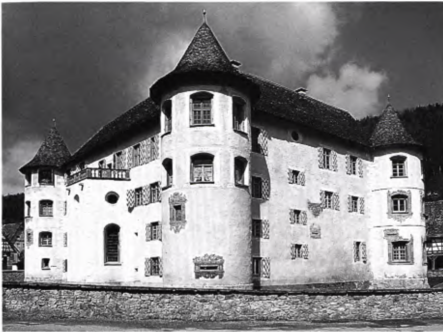
■ 1 Das Wasserschloß Glatt, Stadt Sulz, Kr. Rottweil.
