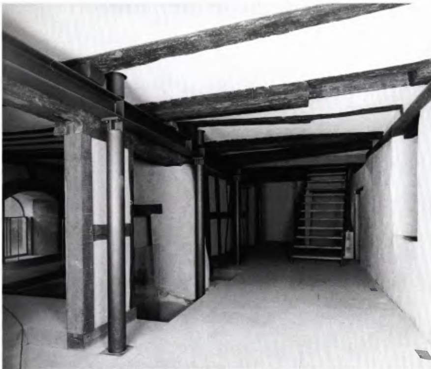
■ 20 Erdgeschoß nach Westen mit Blick auf die neue Erschließungstreppe und die Tragkonstruktion aus Stahl.
