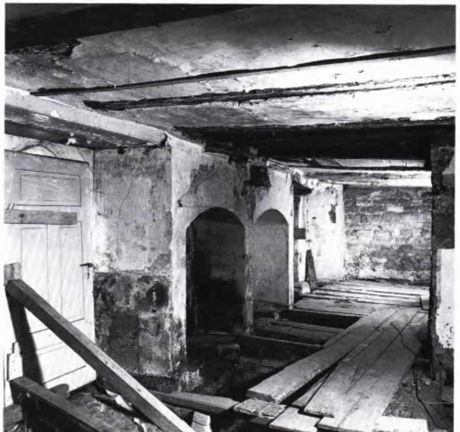
■ 13 Blick von Osten auf die Innenseite der Südfassade mit den beiden originalen Fensteröffnungen, die vor dem Einbau der Keller und der damit verbundenen Anhebung des Fußbodens eine 70 cm hohe Brüstung besaßen. Im Hintergrund sind am Boden die Dielen über dem westlichen Keller erkennbar. Am rechten Bildrand der Ansatz des Kaminblocks (1992).
