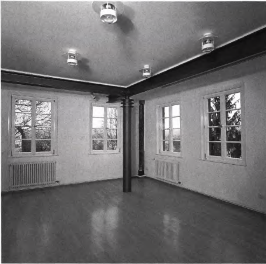
■ 15 Bohlenstube, ca. 1309. Mit zusätzlichen nutzungsbedingten statischen Maßnahmen für den darüberliegenden Bürgersaal.
