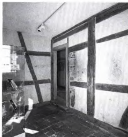
■ 14 Zierfachwerk, 1590, in Zweitverwendung im 18. Jh. zur Zusetzung einer Fensteröffnung verwendet.
