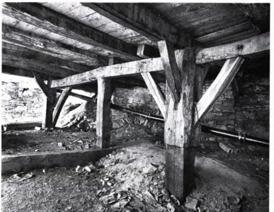
■ 8 Das Stockwerk über dem Keller, ältester Teil des Schlosses, dendrodatiert 1307.
