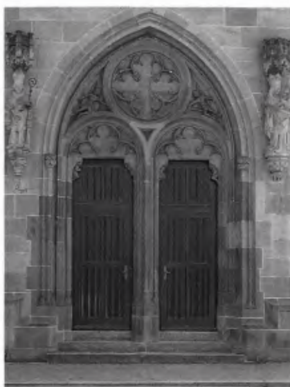
■ 2 Das Westportal der Nikolaikirche.
