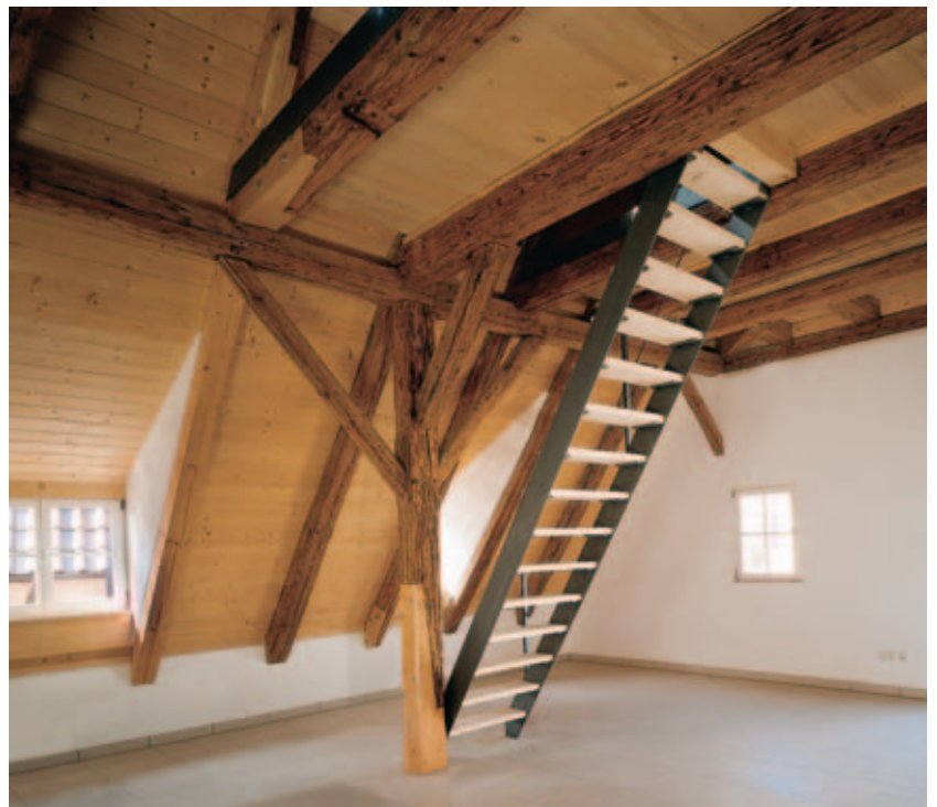
18 Wohnung im Dachgeschoss, mit Treppe zum 2. Dachgeschoss.
