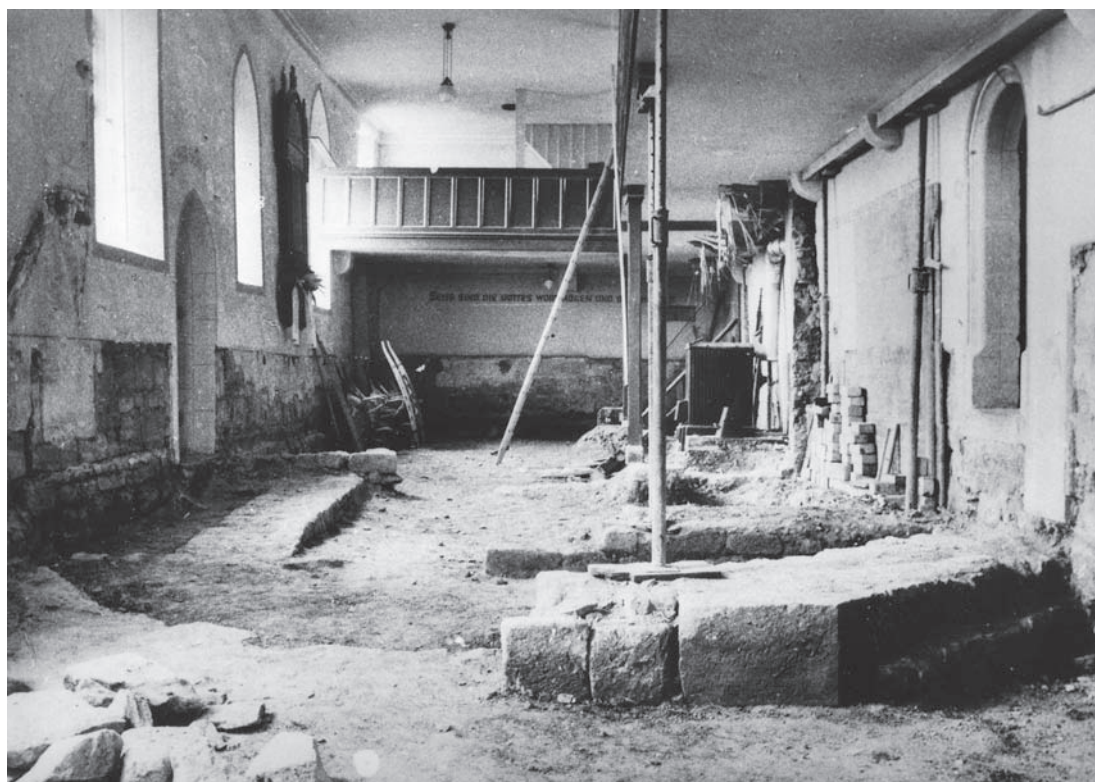
5 Innenaufnahme nach Westen während des Umbaus 1963/64. Im Vordergrund sind die Mauerreste des Chorpolygons der 2. Bauphase erkennbar. An der Nordwand ist rechts noch der Eingang zum Turm sichtbar, die anschließende Wand des Schiffes wird abgebrochen. Die noch erkennbaren Emporen im Norden und Westen wurden gleichfalls abgebrochen; der westliche Eingangsbereich wurde mit einer darüber liegenden Empore neu gestaltet.
