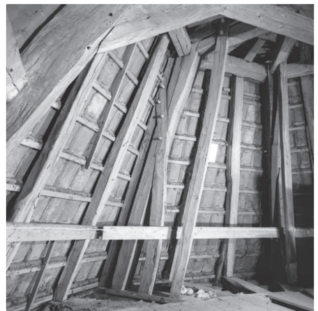
8 Chorpolygon, Binder mit Fuß- und Scherband, Aufnahme von Nordwesten. Die Hölzer des Chorpolygons von 1475/76 wurden bei der Kirchen-erweiterung von 1619/20 wieder eingebaut.
