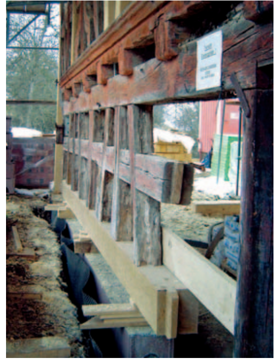
16 Südliche Traufe während der Reparatur, neuer Rähmbalken wird für den Wiedereinbau vorbereitet, Zustand Dezember 2003.
