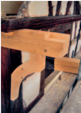
15 Wiederherstellung der Pfettenauskrägung mit knieförmigem Bug für das Flugsparrenpaar am Ostgiebel, Zustand Februar 2004.
