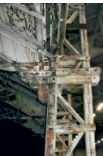
4 Halle 15 und 16, Hauptstütze, Detail (2013).
