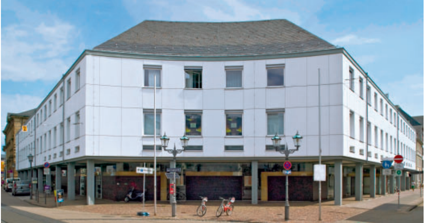
7 Fassade vom Rondellplatz.
