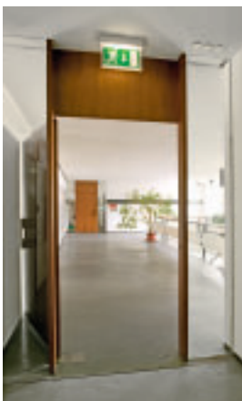
14 Tür zum Treppenhaus, zweites Obergeschoss.
