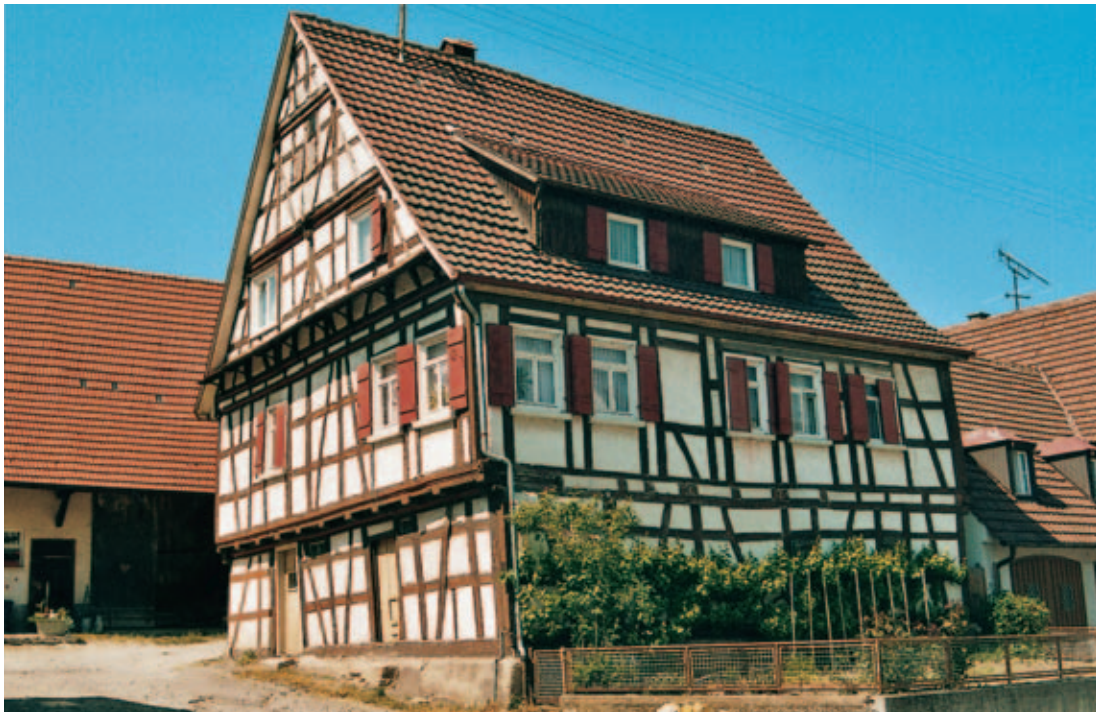
9 Wohl erst auf eine Siedlungserweiterung des 17. und 18. Jahrhunderts zurückzuführen ist die vorwiegend traufständige Bebauung in der Luppachstraße. Das aus dem 18. Jahrhundert stammende Anwesen Luppachstraße 6 zeichnet sich durch ein auskragendes Obergeschoss aus.
