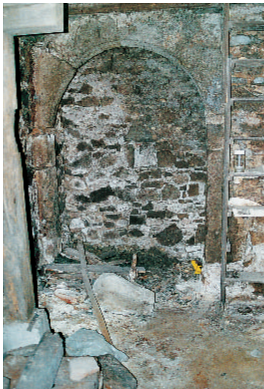
4 Rundbogige Tür in der Ostecke des Kellers.
