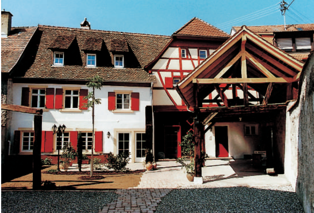
16 Das Gebäude Endingen, Martinskirchgässli 4, nach Abschluss der Renovierung im Juni 2000.
