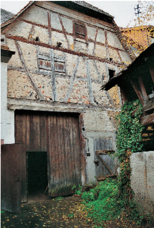
5 Scheune vor der Renovierung.
