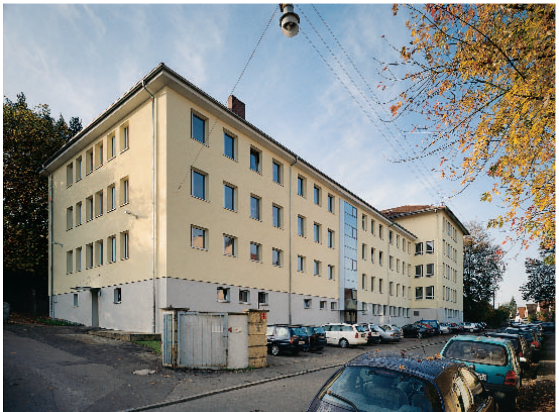
1 Gesamtansicht der Außenstelle Tübingen von Nordosten.
