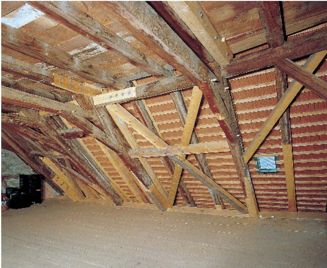
10 Zweites Dachgeschoss nach der Sanierung mit Reparaturstellen und Ergänzungen an Bindern, Pfetten, Sparren und dem Windverband.
