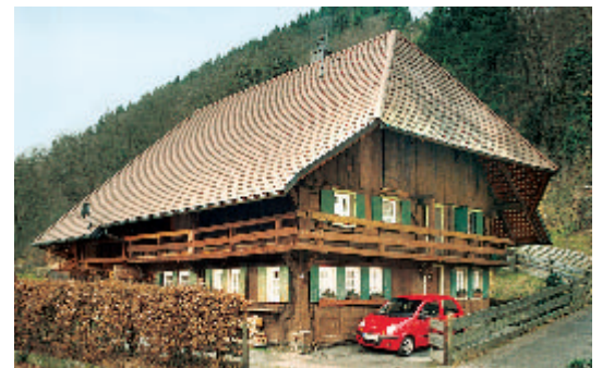
12 Münstertal, Felsengasse 3, ein Eindachhof mit stehender, verblatteter Dachkonstruktion, errichtet 1718.
