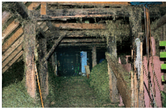
10 Die bislang älteste bekannte Konstruktion eines Münstertäler Hauses aus dem Jahre 1680 findet sich im Gebäude Stampf 12.
