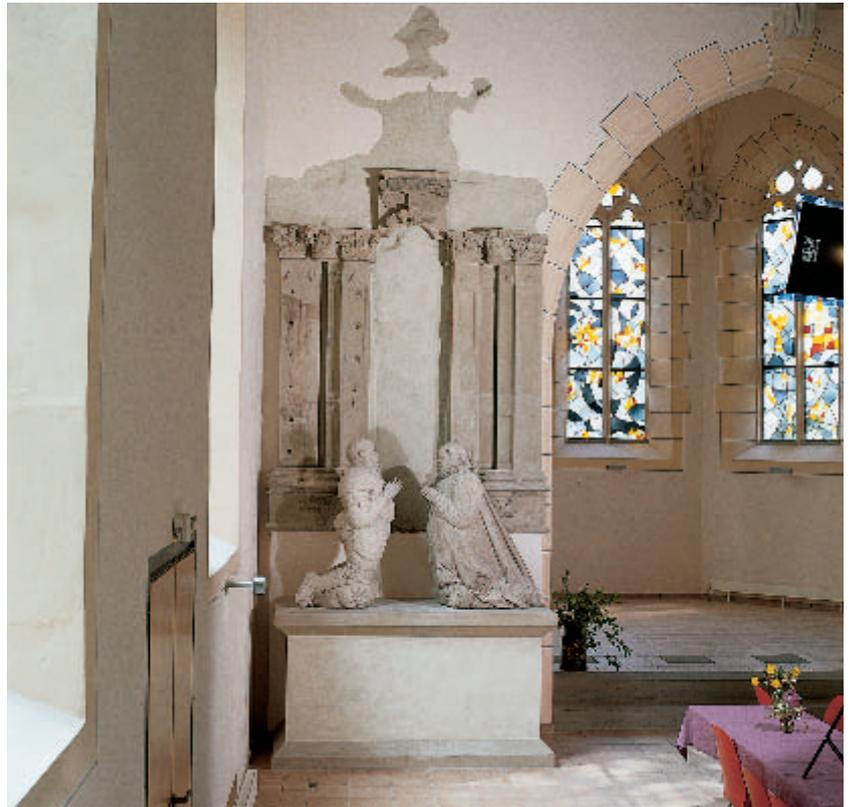
terbau jedoch unabdingbar. Das Landesdenkmalamt gab die Fertigung eines einfachen Mensakubus mit etwas auskragender, gefaster Abdeckplatte vor. Als Anhaltspunkte für Position und Größe des figurentragenden Unterbaus, dienten die Lage der Grablege, das freigelegte Fundament, die Abmessungen der Figuren sowie die Sockelgestaltung bei Vergleichsobjekten.
