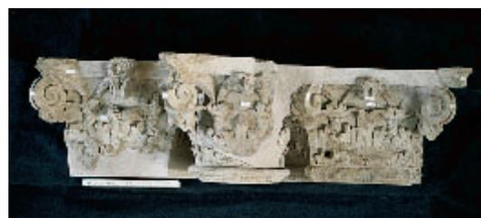
7 Restaurierte Kapitellzone. Die Einzelteile wurden miteinander verklebt bzw. kluftüberbrückend verdübelt. Mittels Mörtelergänzung wurde die architektonische Grundform des Bauteils wieder hergestellt. Eine Ergänzung fehlender Schmuckelemente war nicht vorgesehen.
