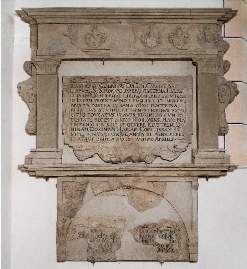
9 Teilrekonstruktion des Karlschen Epitaphs im Chor der Schlosskapelle. Speziell an der unteren Inschrifttafel und am Wappenfries waren größere Ergänzungen erforderlich. Als statisch notwendige Bauteile wurden die beiden Pilaster rekonstruiert.
