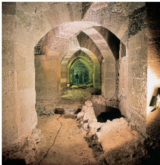
14 Altes Schloss. Westflügel des Untergeschosses nach Norden. Die Pfeiler stehen auf der Ringmauer der Burg, die gegen die hofseitige Wand des Schlossflügels durch Bögen verbunden wurde.
