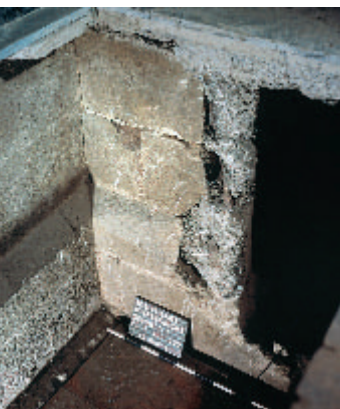
3 Ansatz des spätromanischen Chors an den Südturm.
