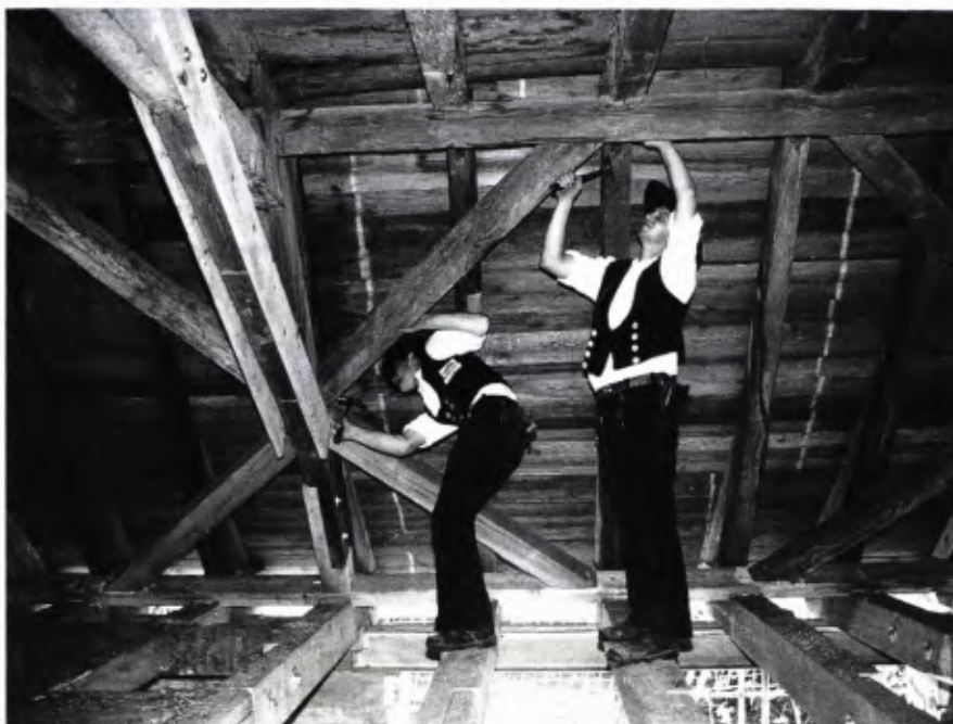
■ 3 Stuttgart-Stammheim. Sanierung des Dachstuhls der ehemaligen Kelter beim Schloß in traditioneller Zimmermannsarbeit.
