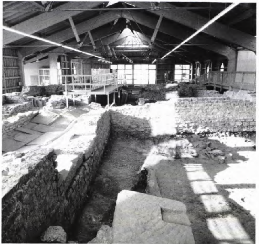
■ 2 Walheim, Römerhaus. Schutzhaus über den restaurierten Mauern und Anlagen eines römischen Gewerbe- und Handelshauses in der römischen Siedlung.
