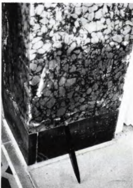
■ 14 Salzausblühungen und Dunkelfärbung des Stuckmarmors im Sockelbereich durch Feuchtigkeit (im Vordergrund Kugelschreiber als Größenvergleich).
