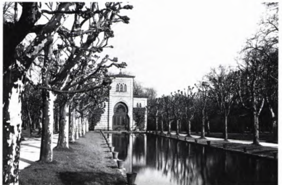
■ 13 Damaszenerhalle mit Langem See, ca. 1910/1920. Wilhelma, Stuttgart.
