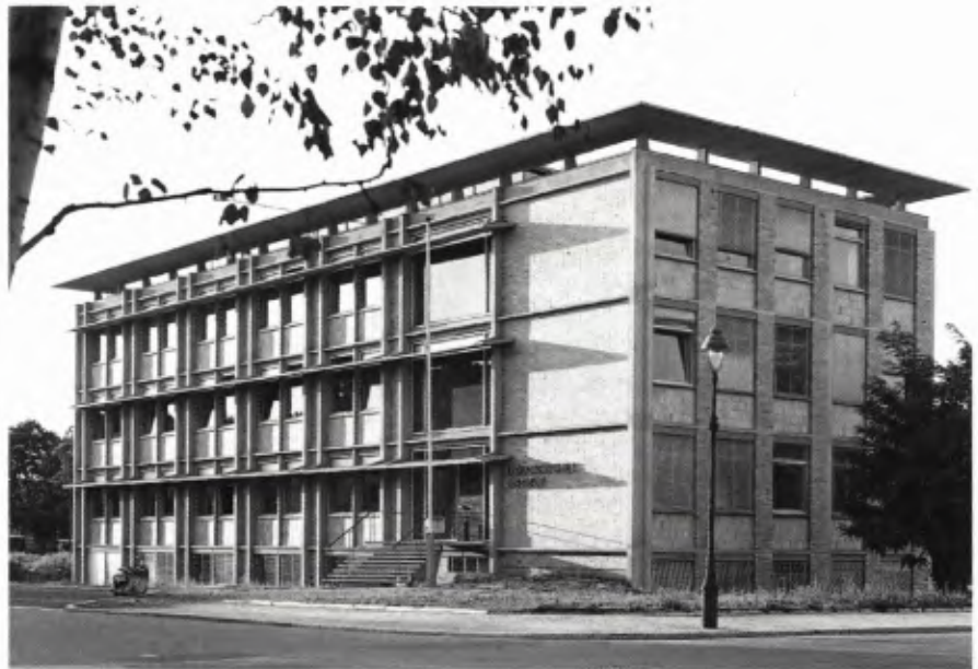
■ 1 Freiburg. Institut für Biophysik und Strahlenbiologie, nach der Fertigstellung im Jahr 1954.
