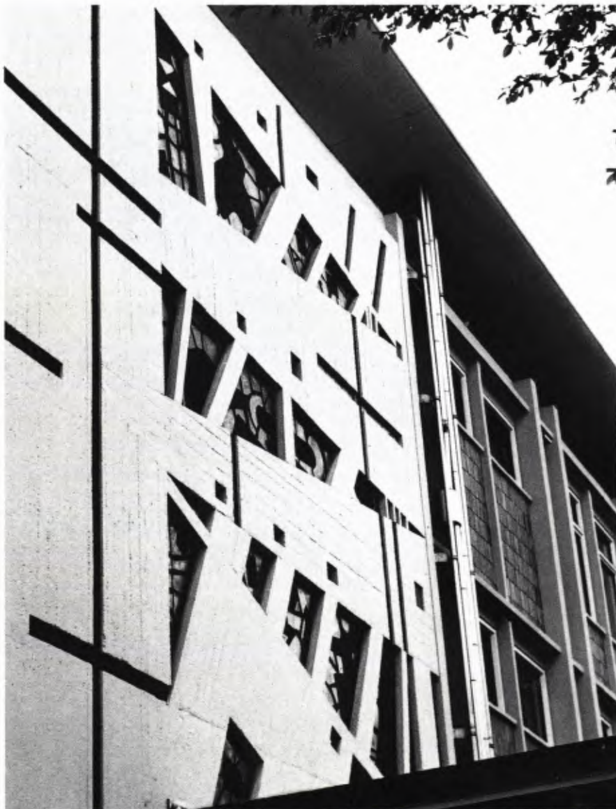
■ 3 Fensterwand von Georg Meistermann: Betonsanierung unter Erhalt der Struktur der Holzschalung.
