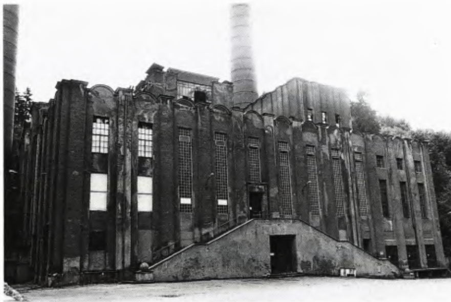
■ 1 Rottweil, Pulverfabrik. Hauptfassade des Kraftwerks von Prof. Paul Bonatz (1915/1916).
