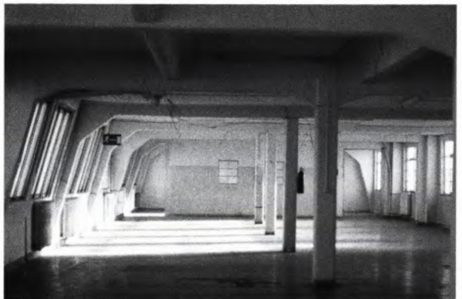
■ 3 Zweischiffige Fabrikationshalle im 1. OG vor dem Umbau.
