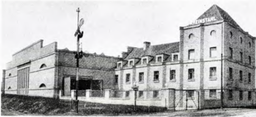
■ 1 Rheinstahl-Werk in Stuttgart-Feuerbach, erbaut 1923 von E. Fahrenkamp. Foto von 1925. Aus: Stuttgart, das Buch der Stadt. Hrsg. von F. Elsas, Stuttgart 1925.
