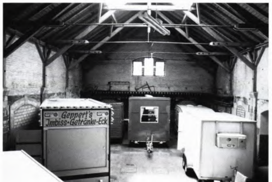
■ 2 Karlsruhe, die Wiegehalle der Kleinviehmarkthalle vor dem Umbau.
