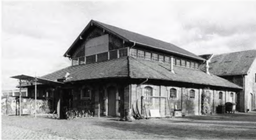
■ 1 Karlsruhe, soziokulturelles Zentrum „Tollhaus“, früher die Kleinviehmarkthalle des Schlachthofes.
