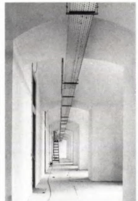
■ 4 Erschließungsflur im Erdgeschoß.
