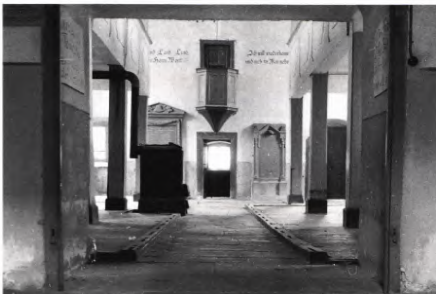
■ 2 Der Kirchenraum vor dem Umbau, Blick zur Kanzel.
