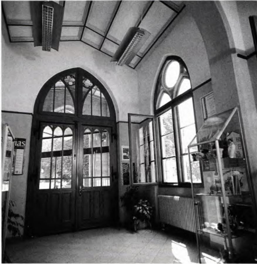
■ 6 Die ehemalige Eingangshalle des Bahnhofs; heute Stadt-Information; rechts ein Kastenfenster.
