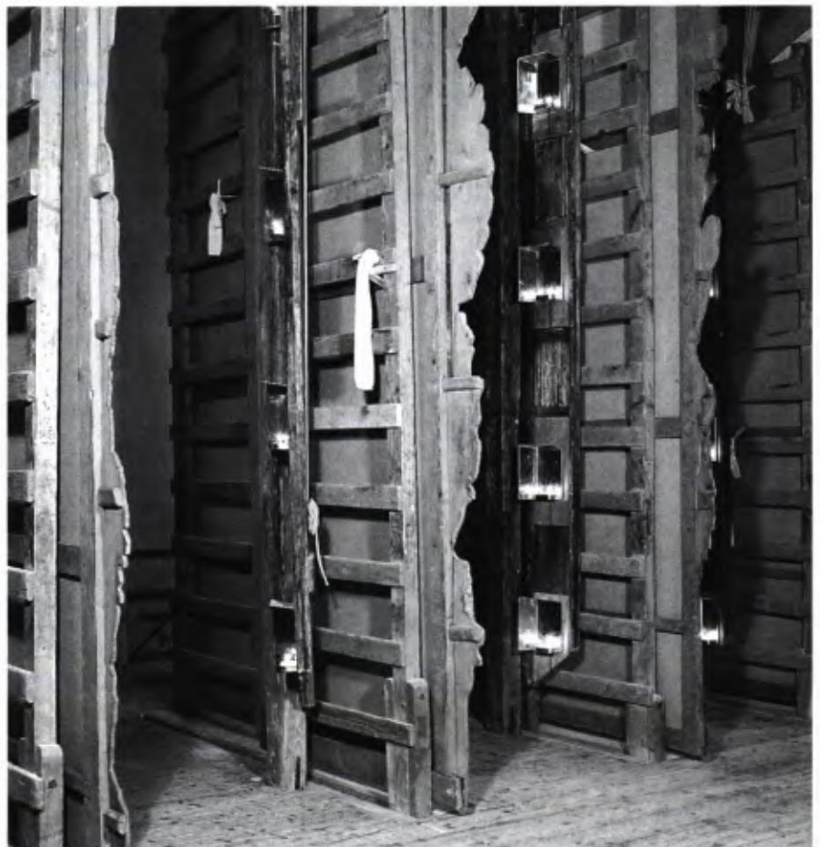
■ 14 Schloßtheater Ludwigsburg, Obermaschinerie mit alten und neuen Teilen 1998. Photo: Staatl. Vermögens- und Hochbauamt Ludwigsburg.
