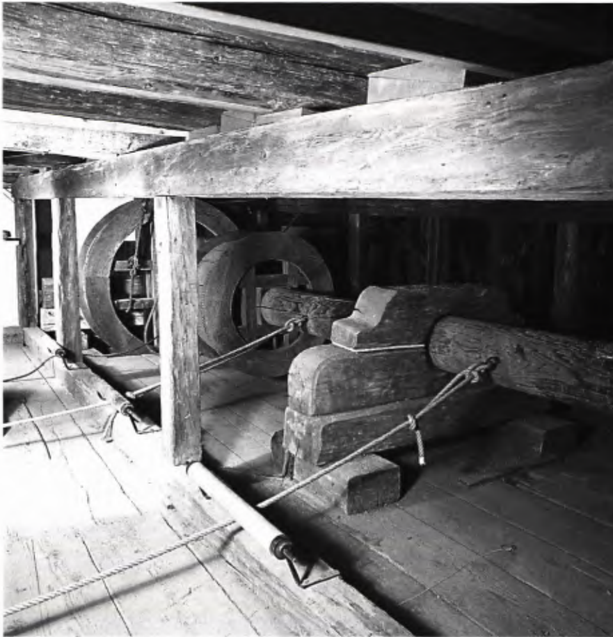
■ 11 Schloßtheater Ludwigsburg, Untermaschinerie mit Wellbaum für die zentrale Verwandlung, Zustand 1998. Photo: Landesbildstelle Württemberg, Stuttgart.
