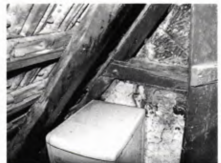
■ 4 Detailsicht der Dachkonstruktion von Kirchstraße 18 mit verblatteter Holzverbindung. Photo: LDA Stuttgart.
