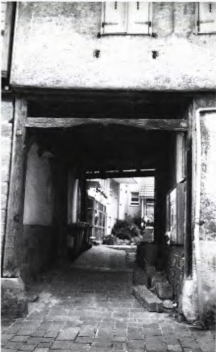
■ 6 Die Durchfahrt des Rebmannhauses mit dekorativem Sturzriegel. Photo: Breuer, Stuttgart.
