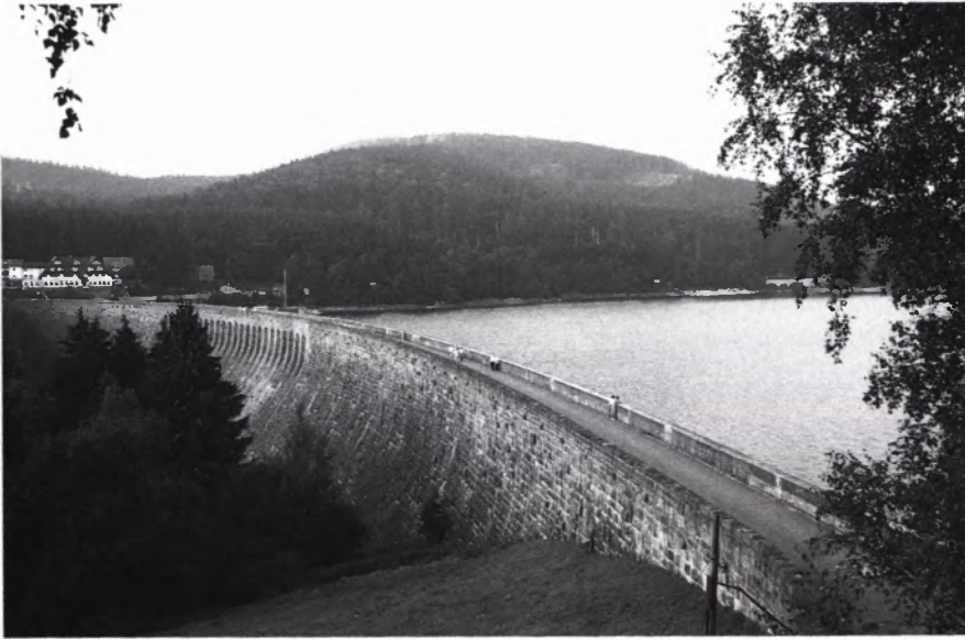
■ 4 Stausee und Staumauer der Schwarzenbachtalsperre von 1922/26 bei Forbach-Herrenwies (Kreis Rastatt). Talseitig wurde die 400 m lange und 60 m hohe Betonmauer mit Murgtaler Granit verkleidet (Aufnahme 1995).
