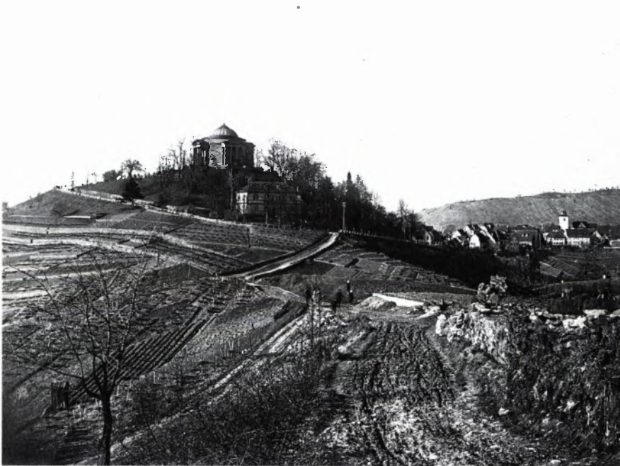
■ 1 Blick von Süden auf die 1820–24 für Königin Katharina erbaute Grabkapelle bei Stuttgart-Rotenberg (Foto vor 1939). Das nach Entwürfen des Hofbaumeisters Giovanni Salucci ausgeführte Bauwerk trat an die Stelle der abgetragenen Stammburg des Hauses Württemberg.
