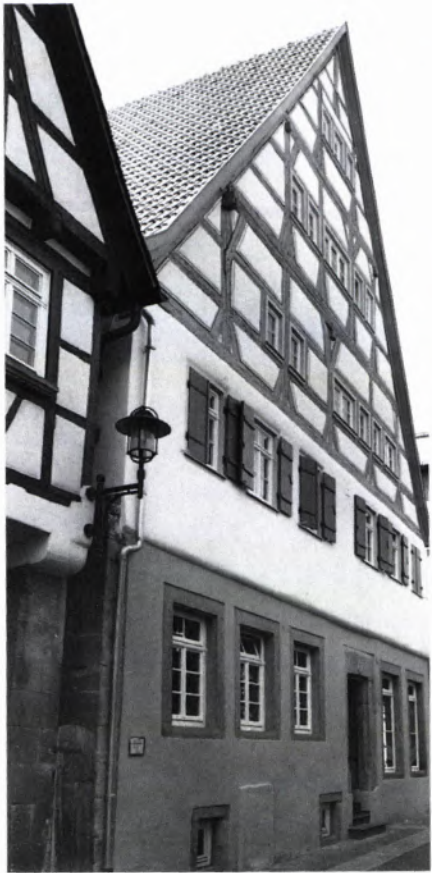
■ 25 Bönningheim, ehem. Sachsenheimer Hof (Hauptstr. 45) nach Abschluß der Renovierungsarbeiten 1996.
