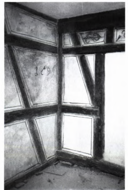
■ 14 Besigheim, Schloßgasse 3, Raum mit Gefachmalerei nach Restaurierung 1996.
