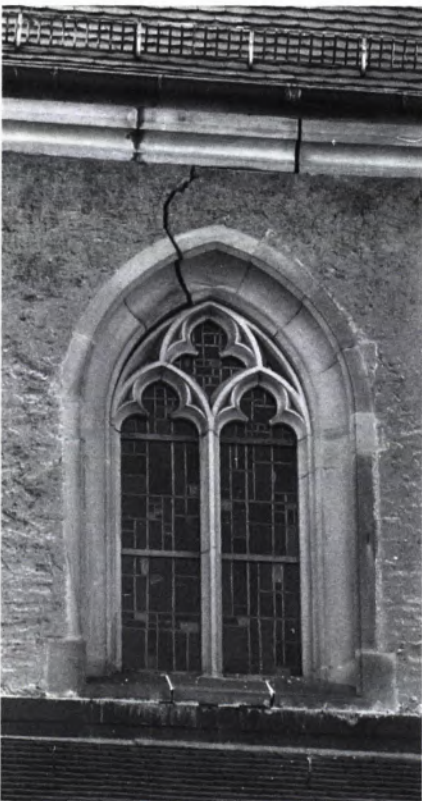
■ 14 Nordseite, Obergaden von Westen. Die Risse über dem Fenster und im Traufgesims haben sich nach der Turmnachgründung verstärkt. Aufnahme April 1993.
