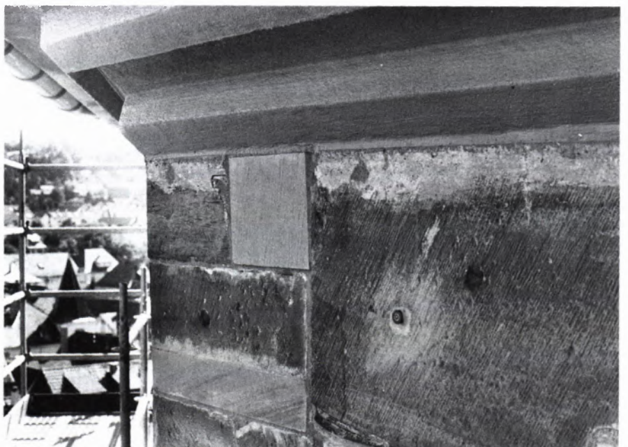
■ 17 Aufnahme während der Sanierungsarbeiten unterhalb des Turmumganges. Die Betonsanierung am Kranzgesims ist abgeschlossen. Darunter mußte ein Stein ausgetauscht werden. In der Mitte des großen Steines befindet sich eine Meßmarke für die Neigungsbeobachtung.
