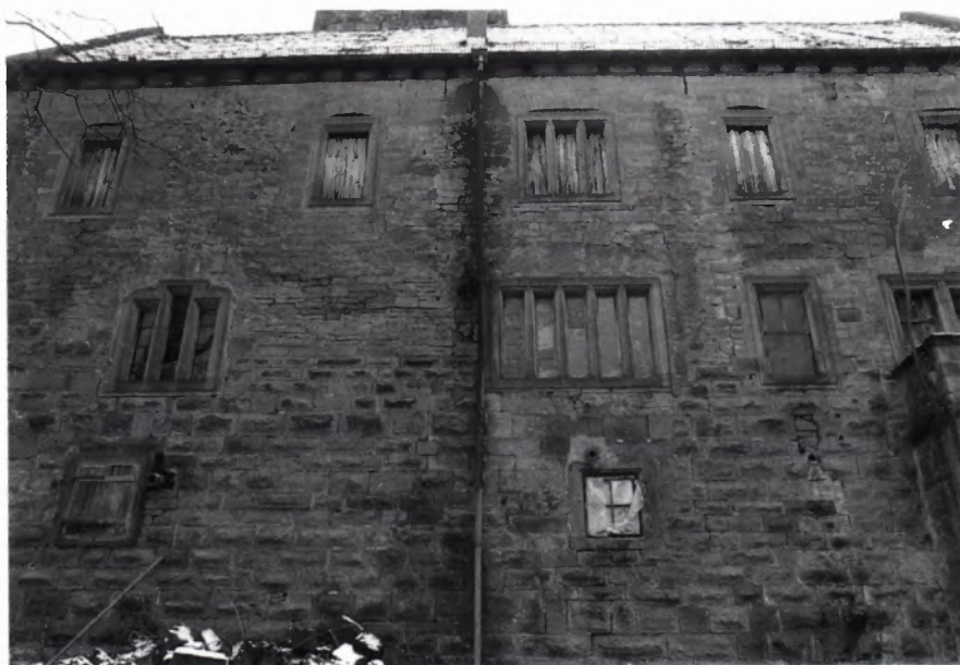
■ 10 Palas, Außenansicht. Foto 1996, LDA.
