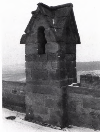
■ 8 Oberer Turm, frühgotischer Schornstein. Foto 1996, LDA.
