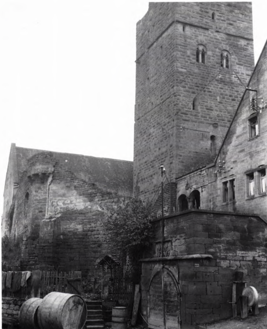
■ 4 Obere Burg, in der Mitte der Donjon, (Oberer Turm), rechts der Bau von De Millas, im Hintergrund der Palas. Foto um 1900, LDA.
