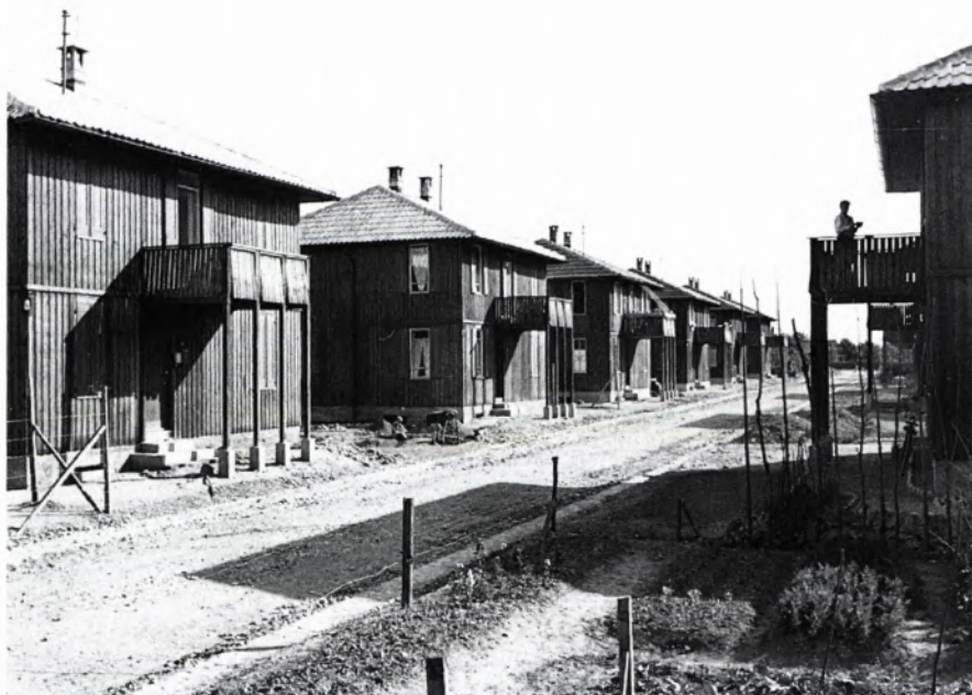
■ 1 „Georgette-Häuser“ in der Oberen Lachen mit der ursprünglich als Gartenseite gedachten Balkonfassade. Bild: Stadtarchiv Freiburg M 75/1, ca. 1948.
